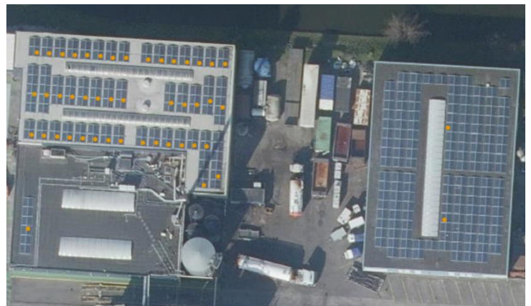
Figuur 3 Voorbeeld zonnepanelen data NEO
